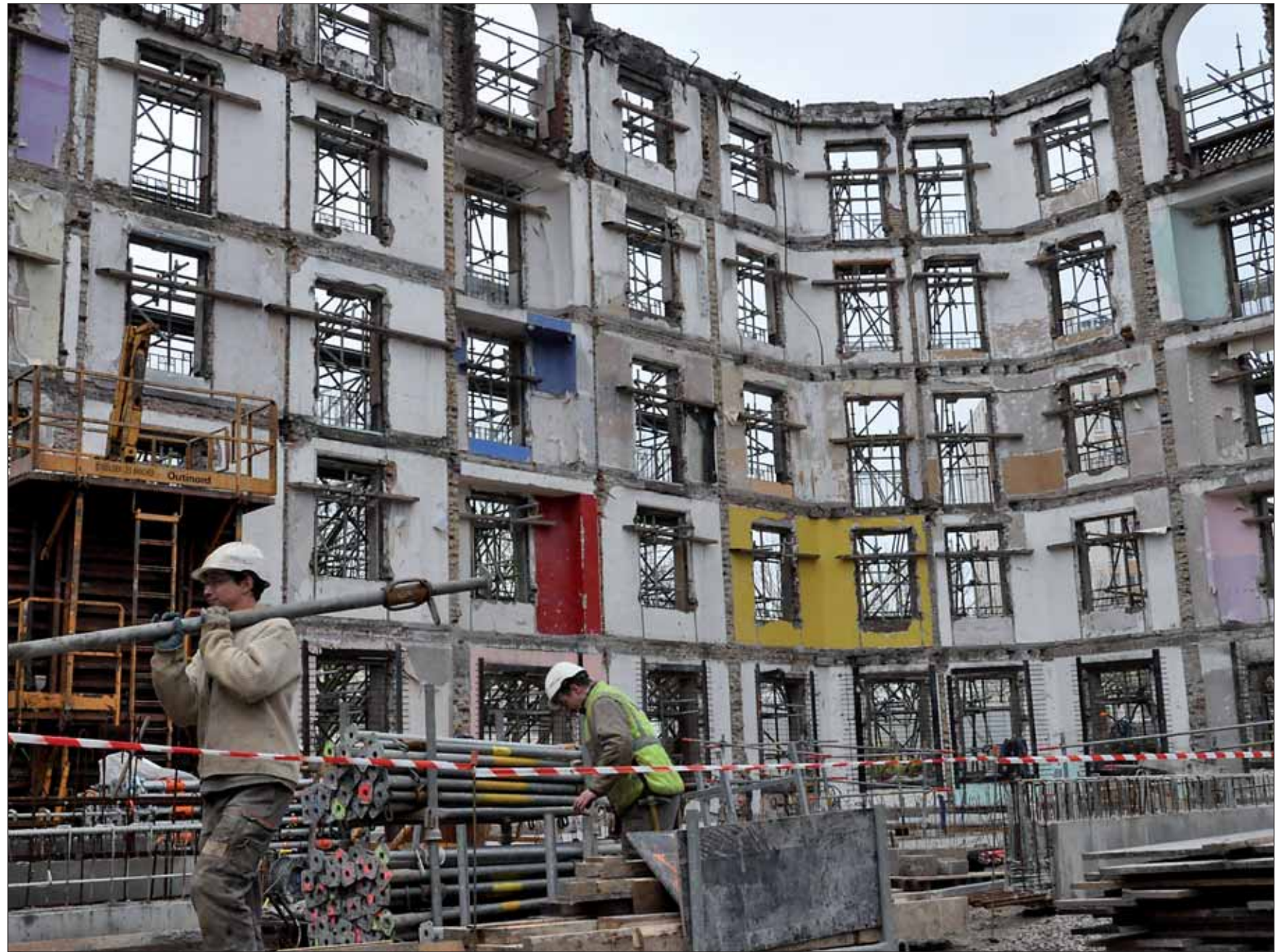
Une démolition sur mesure pour préserver l'ancienne façade vue ici de l'intérieur.
