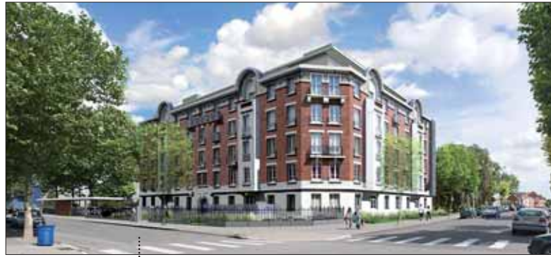
La façade historique a été préservée dans le nouveau projet qui présente 45 appartements tout confort. © Architecte : Nathalie Wiel et Thaddée Ruyant
